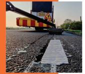
خاصیت بازتابندگی این ذرات از طریق تابش نور چراغ خودروها بر سطح جاده شکل میگیرد.
